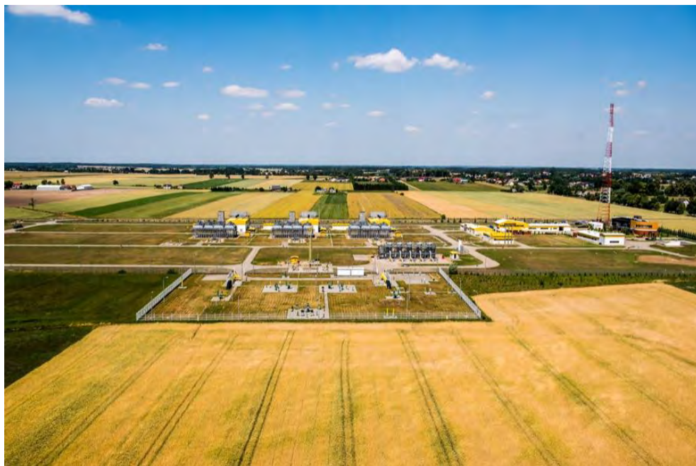
Rys. 2. Widok tłoczni gazu należącej do EuRoPol GAZ s. a [5]
