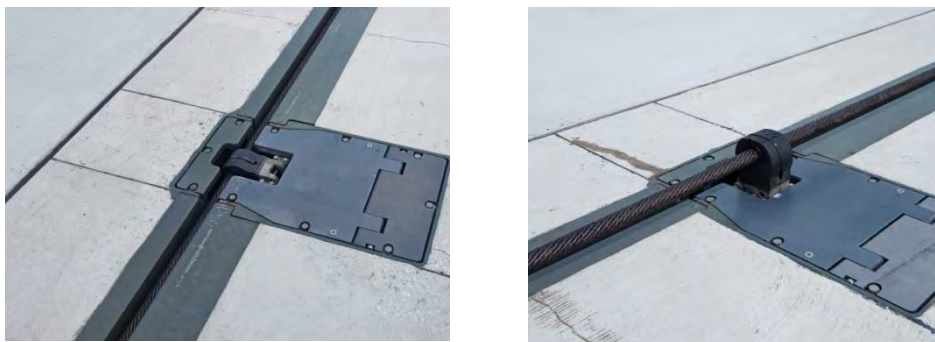
Rys. 2. Urządzenie systemu BAK-12 z chowaną liną wychwytyjącą
