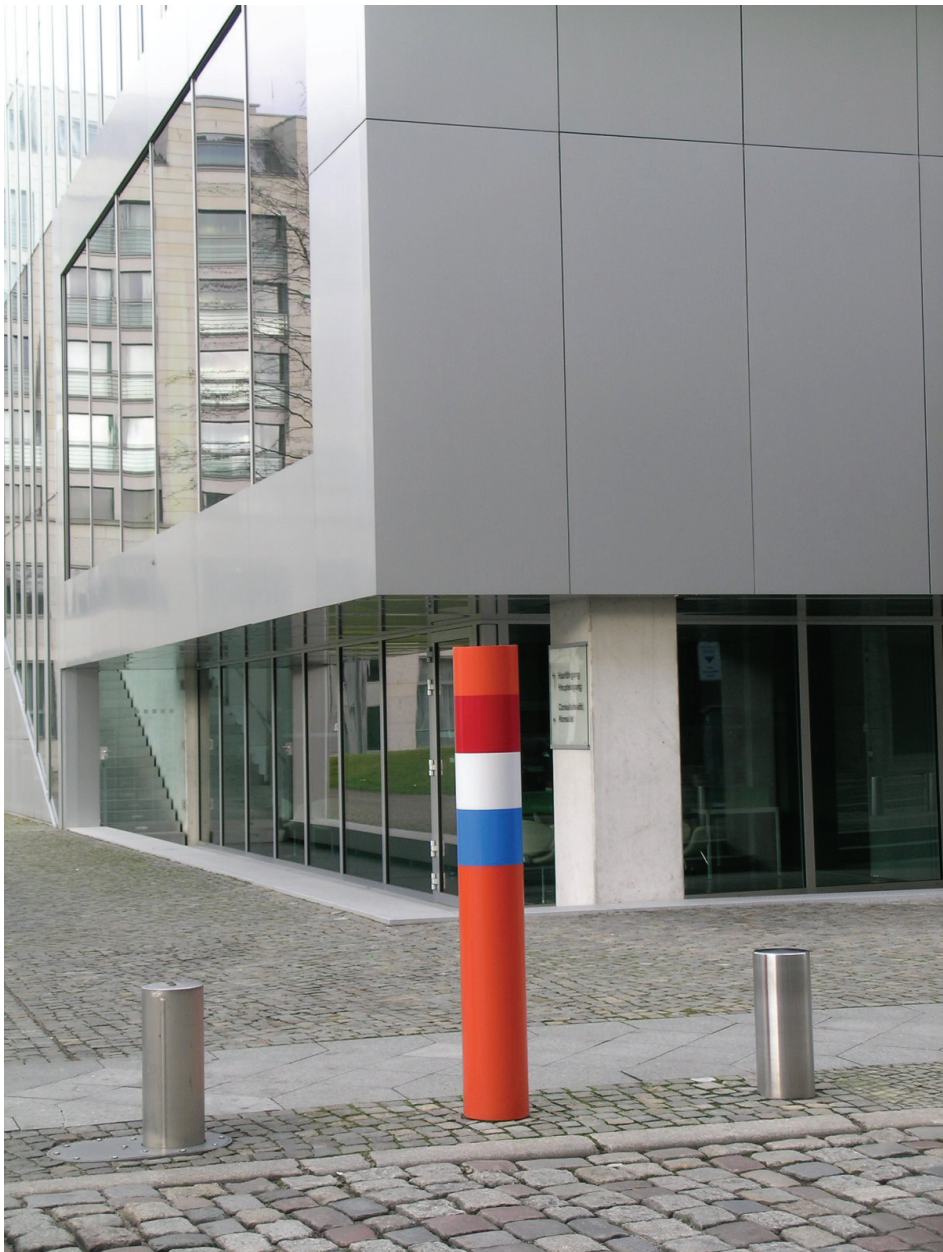
Rys. 2.31. Przykład zabezpieczenia budynku ambasady Królestwa Niderlandów w Berlinie (autor projektu Rem Koolhaas) za pomocą betonowych słupków ograniczających dostęp i uniemożliwiających zaparkowanie pojazdu (fot. A. Nadolny)
