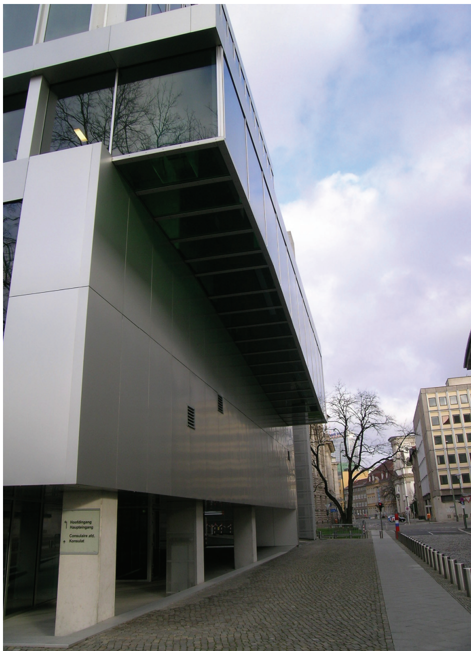
Rys. 2.25. Przykład zabezpieczenia budynku ambasady Królestwa Niderlandów w Berlinie (autor projektu Rem Koolhaas) za pomocą betonowych słupków ograniczających dostęp oraz uniemożliwiających zaparkowanie pojazdu (fot. A. Nadolny)
