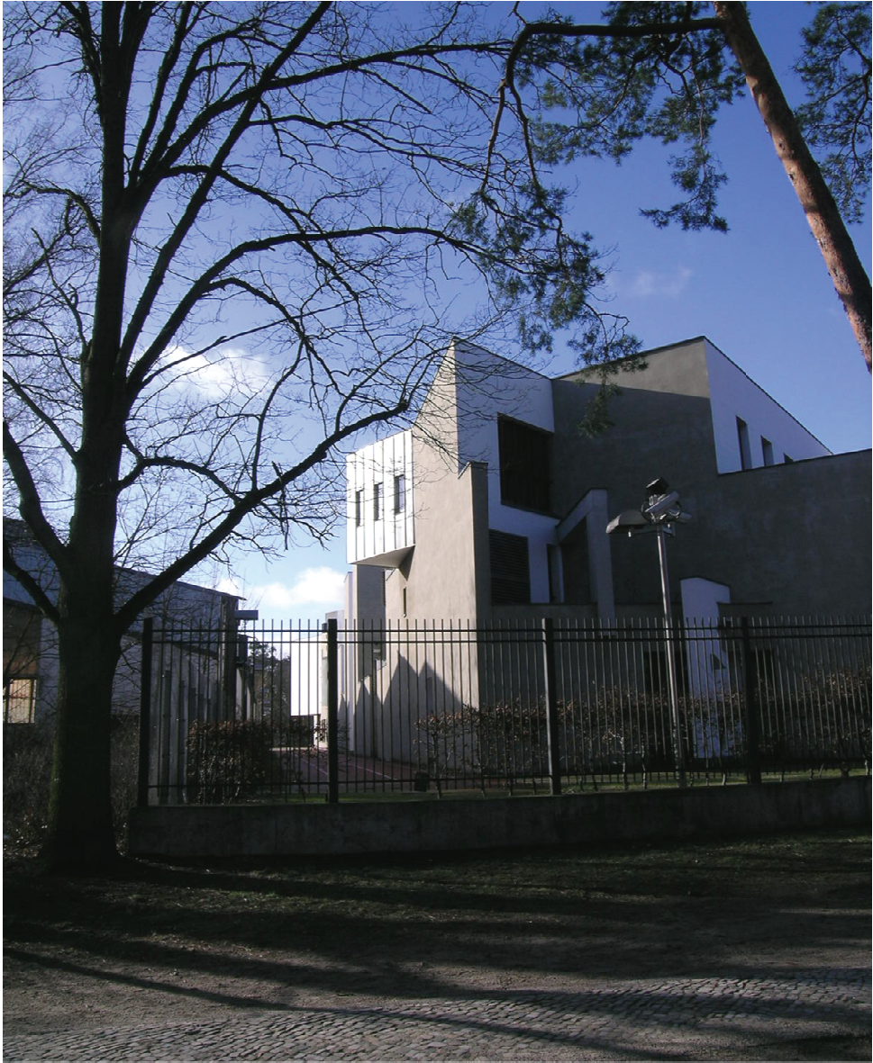
Rys. 2.24. Przykład zabezpieczenia budynku szkoły żydowskiej w Berlinie (autor projektu Zvi Hecker): kontrola dostępu, wprowadzenie od strony ulicy ażurowego ogrodzenia o wysokości ponad 2,40 m i system monitoringu – kamery (fot. A. Nadolny)
